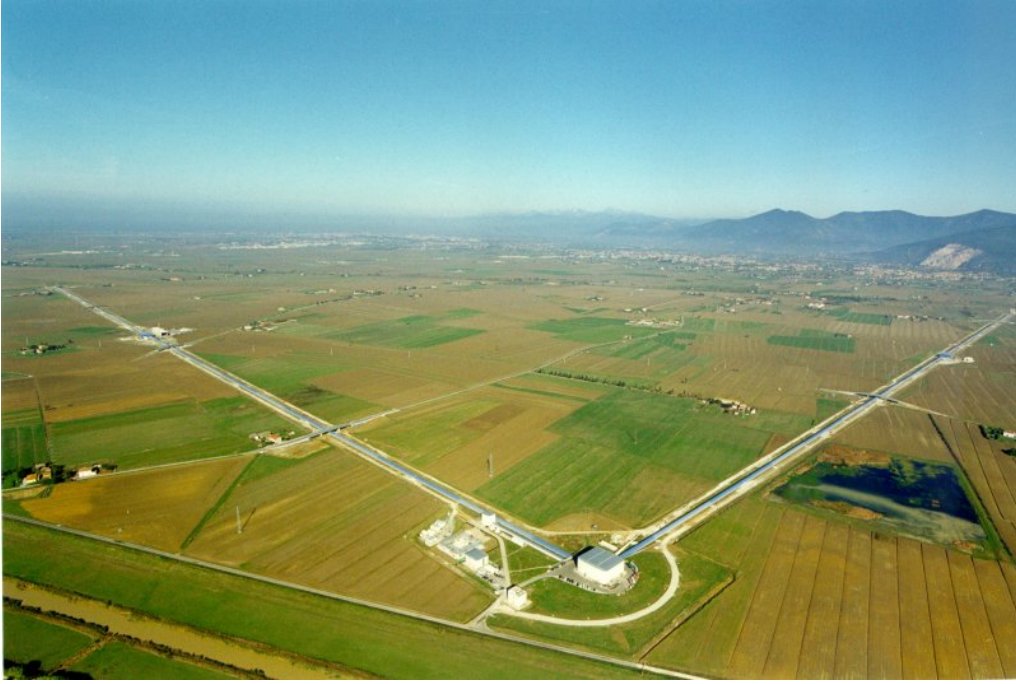
FIGURE 6.1 – Vue aérienne du détecteur interférométrique d’ondes gravitationnelles VIRGO, situé à Cascina, près de Pise (Italie). La construction de VIRGO s’est achevée en 2003. Les cavités Fabry-Pérot de chacun des bras de 3 km ont été alignées avec succès et les premières franges d’interférence ont été obtenues en février 2004. Le détecteur est actuellement en phase d’acquisition de données à une sensibilité très proche de sa sensibilité nominale (cf. Fig. 6.5) [source : CNRS / Istituto Nazionale di Fisica Nucleare].
