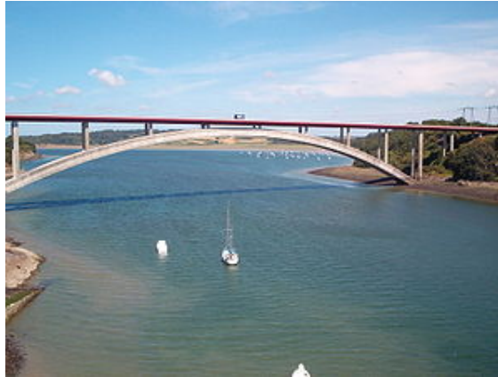
FIGURE 2.12 – Le pont Châteaubriand, pont en béton précontraint ayant la plus grande portée en France
