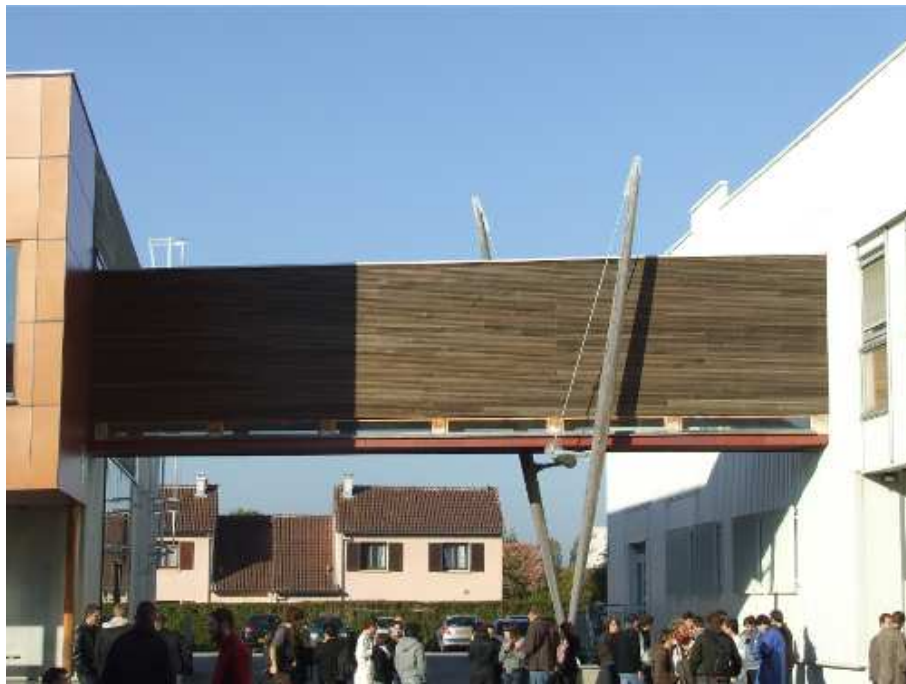
Figure 8.1: Une passerelle supportée par deux poteaux en bois, câbles et rouleau.
