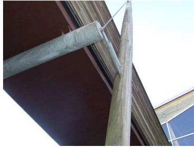
Figure 8.3: Le bras est renforcée par une barre articulée à ses deux extrémités.
