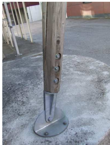
Figure 8.2: La base du poteau est articulée.
