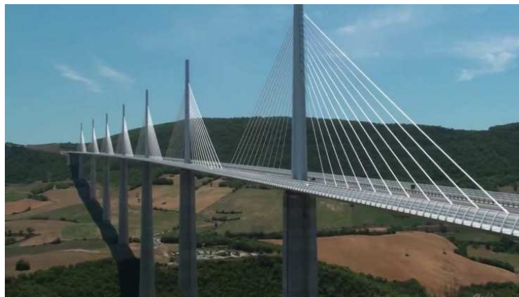
Figure 1.83: Le viaduc de Millau.
