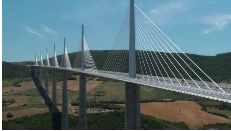
Figure 1.84: Le viaduc de Millau.
