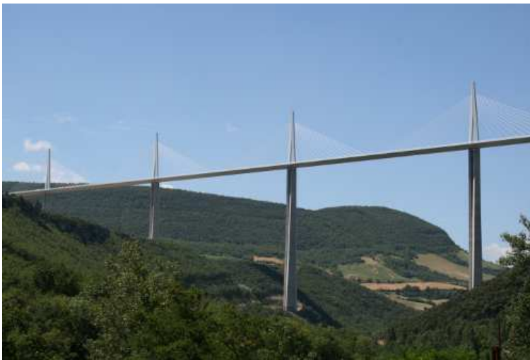
Figure 1.89: Le viaduc de Millau.
