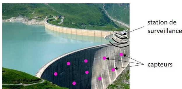
FIGURE 4.14 – Barrage hydroélectrique équipé de capteurs coulés dans la structure.
