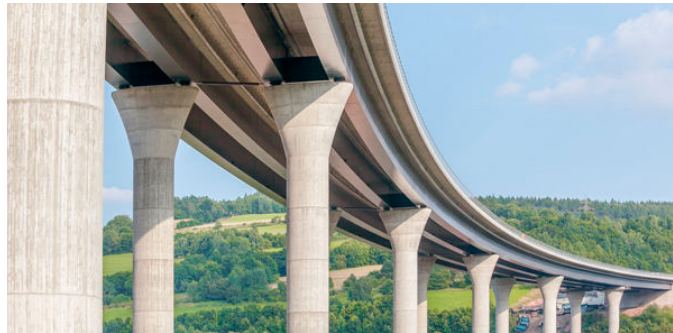
Pont en béton précontraint
