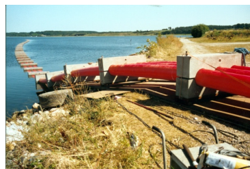
Pose des tubes de protection avant tirage des câbles (400 kV triphasé)
