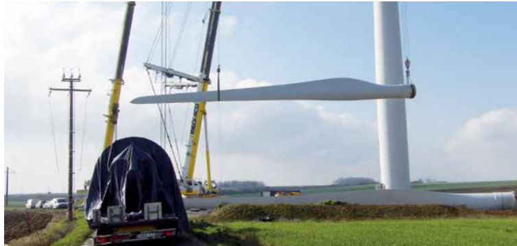
FIGURE 4 – Remplacement d'un roulement sur une éolienne dans les environs de Poitiers (source : 7 à Poitiers, n° 299, 2 au 8 mars 2016, crédit : Sergies / Le 7).
