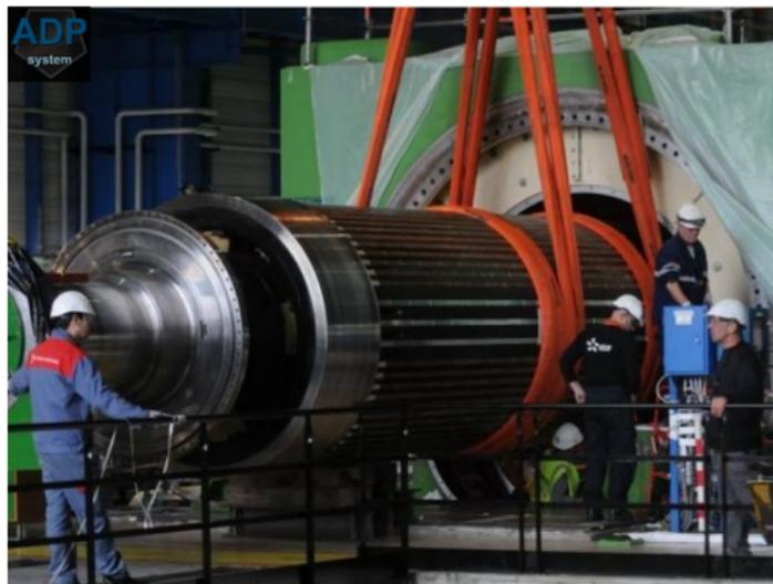
Rotor d'une centrale hydroélectrique.
